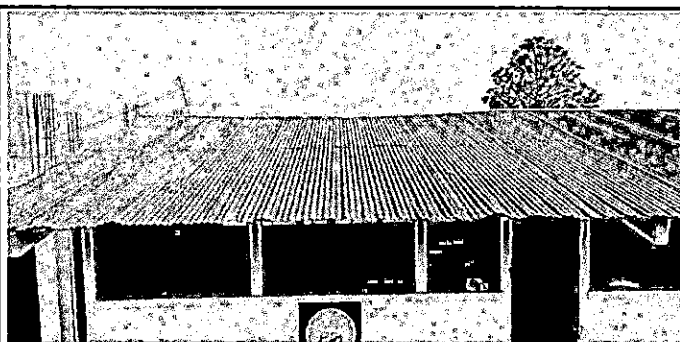
Foto 5 Lamina en mal desgastada
